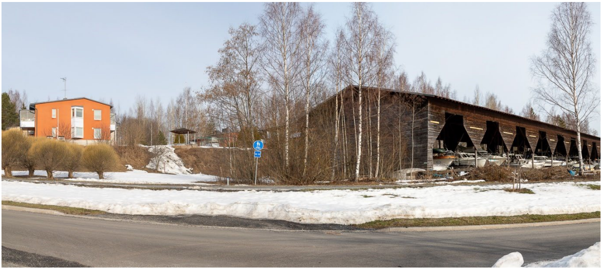
Näkymä Sahantieltä Sataman suunnasta kohti kaavamuutosaluetta. Kaavamuutosalue sijaitse venekatoksien takana. Vasemmalla Lautatarhanpolun asuinrakennukset ja oikealla venekatokset.
