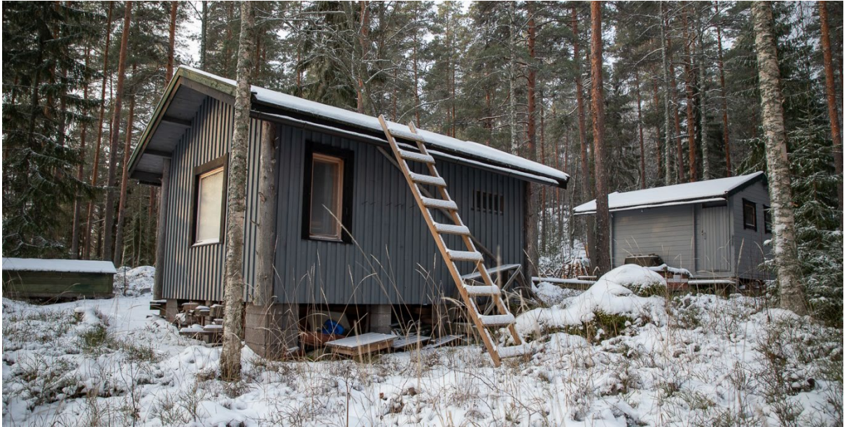
Vasemmalla aitta (talousrakennus) ja oikealla talousrakennus.
