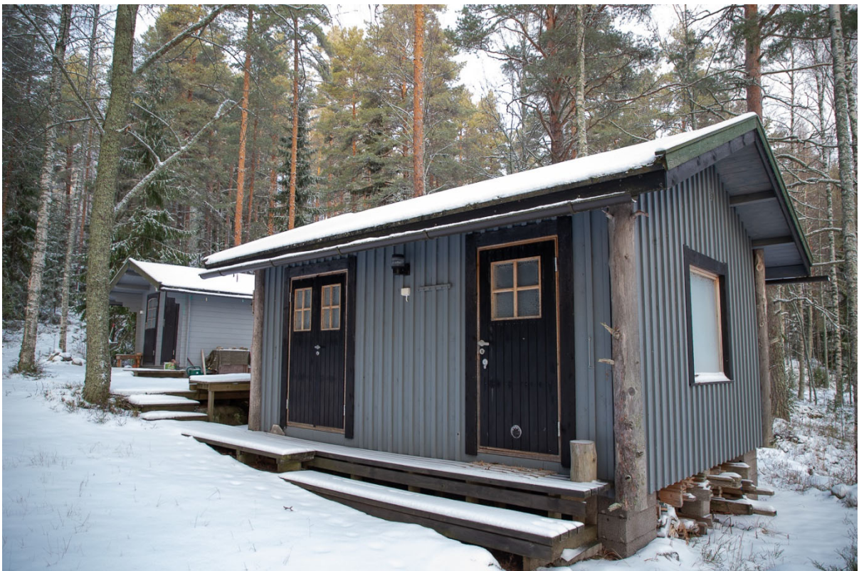
Oikealla aitta (talusrakennus) ja vasemmalla talusrakennus.
