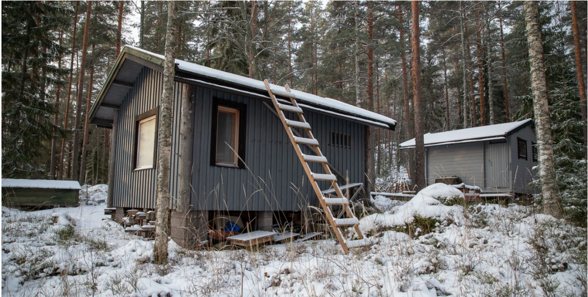
Vasemmalla aitta (talousrakennus) ja oikealla talousrakennus.
