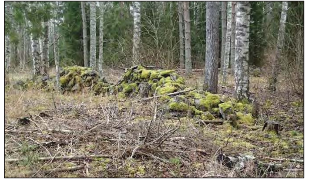
Osittain sortunutta kiviaitaa. Etelään.
